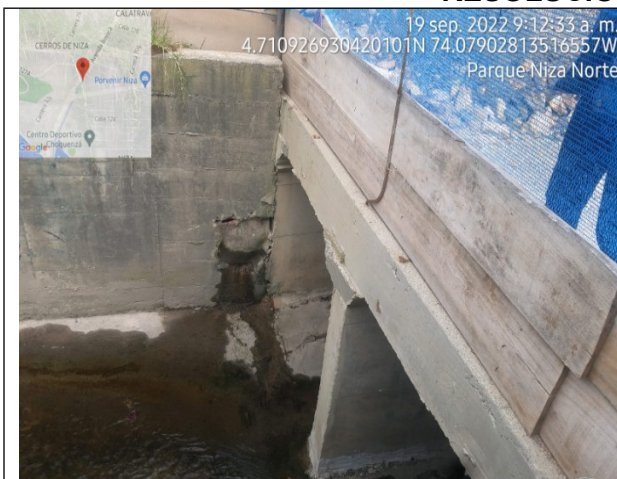
Fotografía No 3. Construcción Box Culver, Sección Oriental, Calle 127 con Av Boyacá, Canal Niza.
