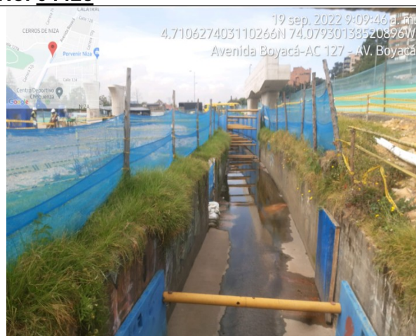
Fotografía No 4. Construcción Box Culver, Sección Oriental, Calle 127 con Av Boyacá, Canal Niza.
