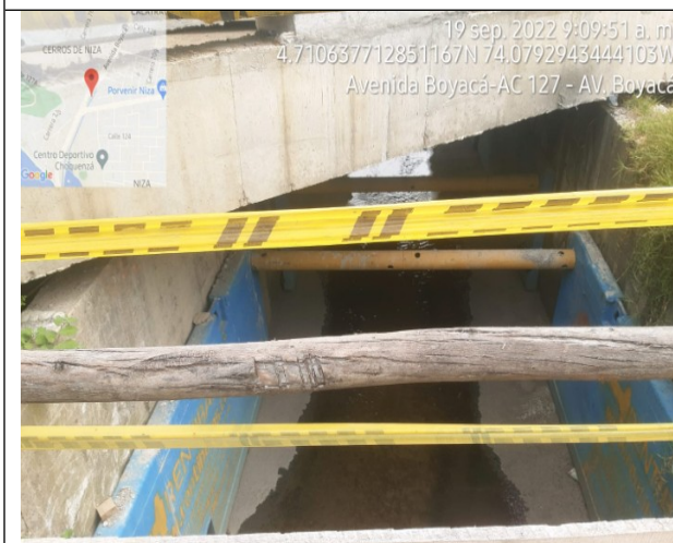
Fotografía No 5. Construcción Box Culver, Sección Oriental, Calle 127A con Av Boyacá, Canal Niza.
